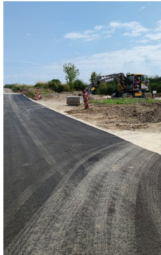
Fot. 4.3 Zatoka autobusowa w Kamieniu w trakcie realizacji inwestycji ( www.jablonowopomorskie.pl )
