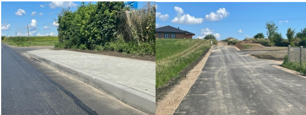
Fot. 4.76 i 4.7. Budowa zatoki autobusowej w miejscowości Kamień (źródło: UMiG Jabłonowo)
