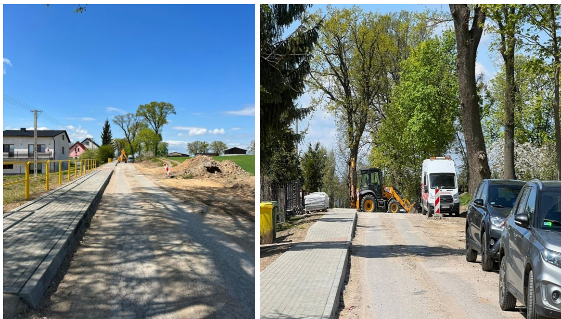
Fot. 4.13 i 4.14. Przebudowa drogi gminnej Konojady-Tomki odcinek od km 0+000 do km 0+810,00 - etap I (źródło: UMiG Jabłonowo)
