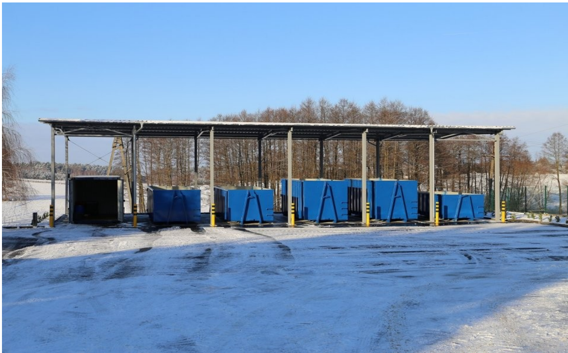
Fot. 4.9. Wiata na kontenery PSZOK (źródło: UMiG Jabłonowo)
