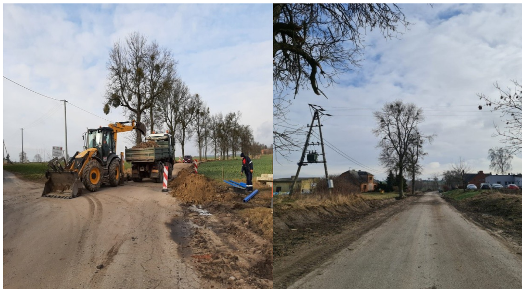
Fot. 4.11 i 4.12. Przebudowa drogi gminnej Buk Pomorski – Świecie nad Osą - etap II" (źródło: UMiG Jabłonowo)
